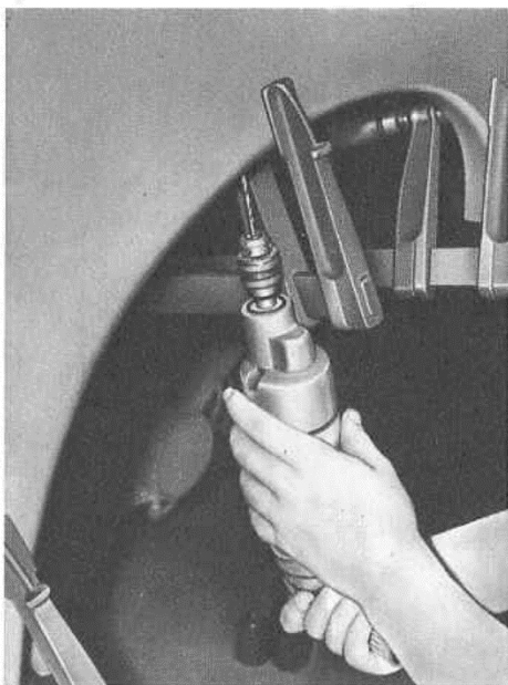
Bild K 16. Nietlöcher bohren
