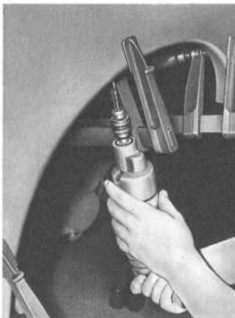
Bild K 16. Nietlöcher bohren
