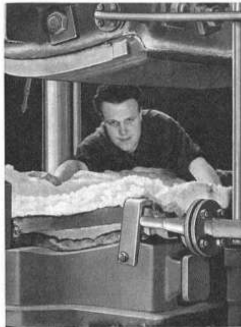
Bild K 7. In Presse einlegen
